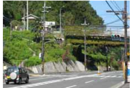
昔の九条山の電停付近
